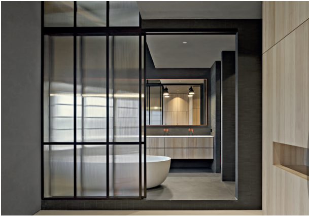
Eine schiebbare Trennwand aus Stahl und Glas schafft eine visuelle Verbindung zwischen Bad und Schlafzimmer.
